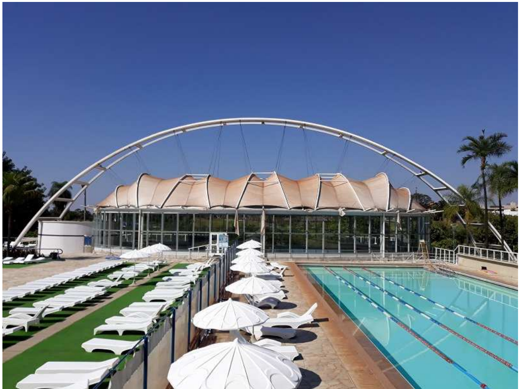
Foto 1 – Vista geral da obra: Arquitetura diferenciada, com a cobertura em lona sustentada por cabos presos a um arco metálico, e fechada com paredes envidraçadas
