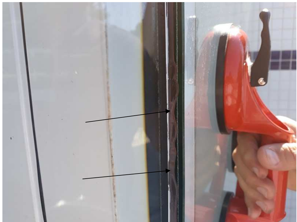
Foto 13 - Um pequeno esforço de tração já é suficiente para soltar os vidros.
