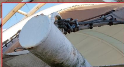
DETALHE - TENSIONAMENTO CABO DE AÇO VINCO NA LONA
