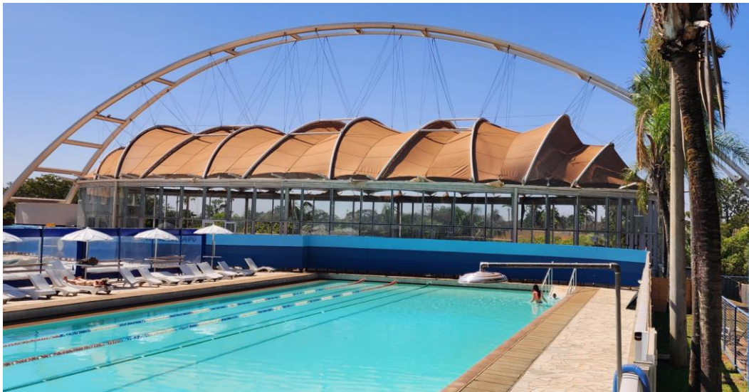
FOTO: Piscina coberta sem uso e sem manutenção, interditada ao uso do associado.
